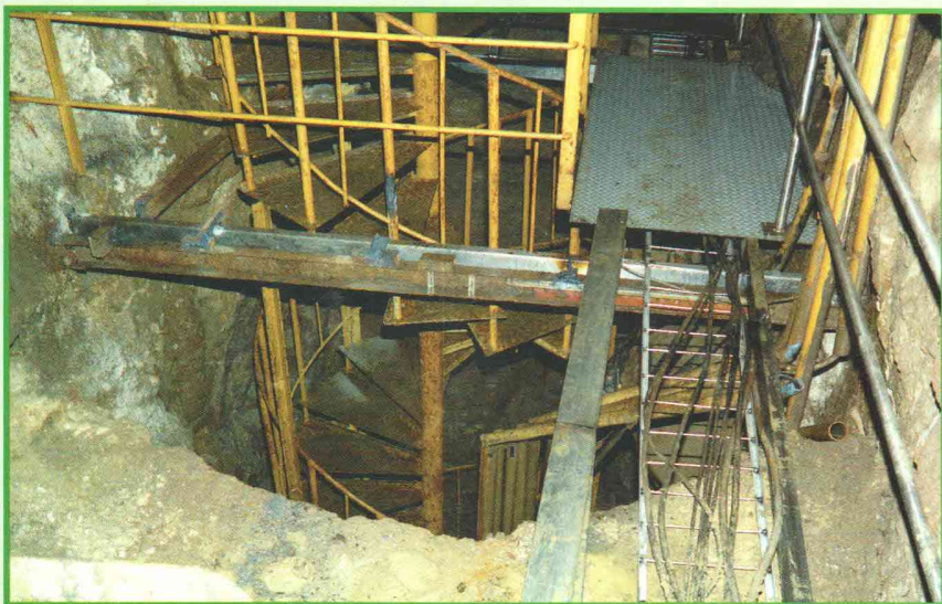
Koněpruské jeskyně, instalace nerezové plošiny v Mincovně v roce 2000.
