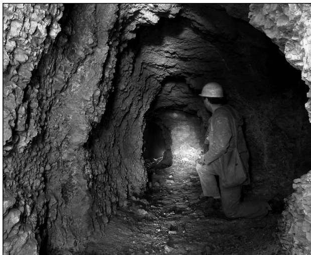
Obr. 3. První pravá rozrážka. Vpravo od postavy je sklípek pro uložení trhaviny (Foto Martin Majer).
