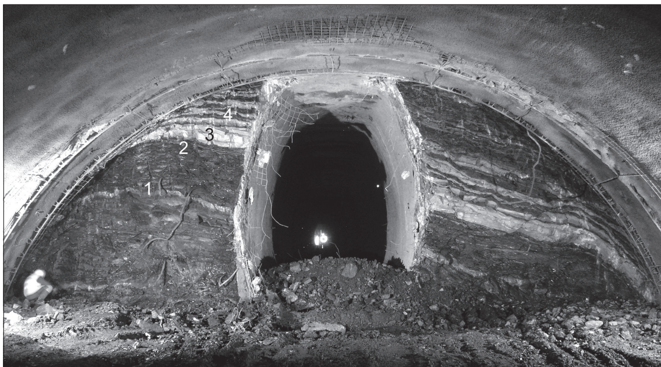
Obr. 10. Svrchní část želkovického souvrství a spodní část lithlavského souvrství odkryté v čelbě třípruhového tunelu. Poloha bioturbovaného prachovce ve spodní části graptolitové zóny Stimulograptus sedgwickii je označena číslem 1. Bázi lithlavského souvrství tvoří poloha světlého, zelenavého, vápnitého jílovce bez graptolitů (poloha č. 3). Černé břidlice (č. 2) těsně pod touto jílovcovou polohou jsou datovány graptolity svrchní části zóny St. sedgwickii . V prvních černých vložkách nad jílovcem (č. 4) nastupuje fauna zóny Rastrites linnaei . Uprostřed čelby je zastíženo těleso průzkumné štoly „Lahovská“ z roku 2004. Světlo na konci štoly je z portálu u Radotína. Metráž 181,0 m od radotínského portálu. Foto Jakub Bohátka.
