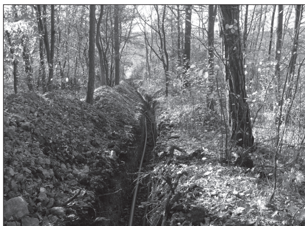
Obr. 2. Průběh kopané rýhy přímo v trase zelené turistické značky. Foto P. Čáp.
