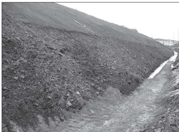
Obr. 4. Tektonicky porušené spodní polohy bohdaleckého souvrství odkryté výkopem odvodňovací rýhy jz. partie odkryvu č. 5, jz. pokračování profilu vyobrazeného na obrázku 2.
