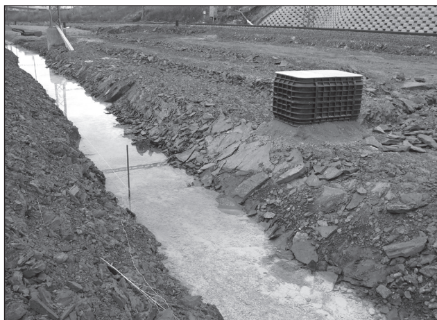
Obr. 2. Tektonicky neporušené spodní polohy bohdaleckého souvrství odkryté výkopem odvodňovací rýhy jz. partie odkryvu č. 5. Fig. 2. Tectonically undisturbed lower portions of the Bohdalec Formation exposed in an excavation of a drainage ditch located in the SE part of the outcrop No. 5.
