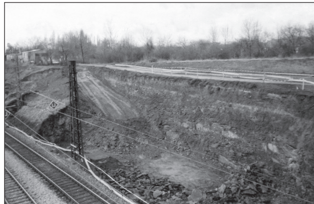
Obr. 3. Stavební jáma s. pilíře nového železničního přemostění koridoru „Nového spojení“; téměř horizontálně uložené prachovce vyšších partií zahořanského souvrství s polohou velkých pelokarbonátových čoček zhruba v polovině odkrytého vrstevního sledu. Odkryv 5a na obrázku 1.
