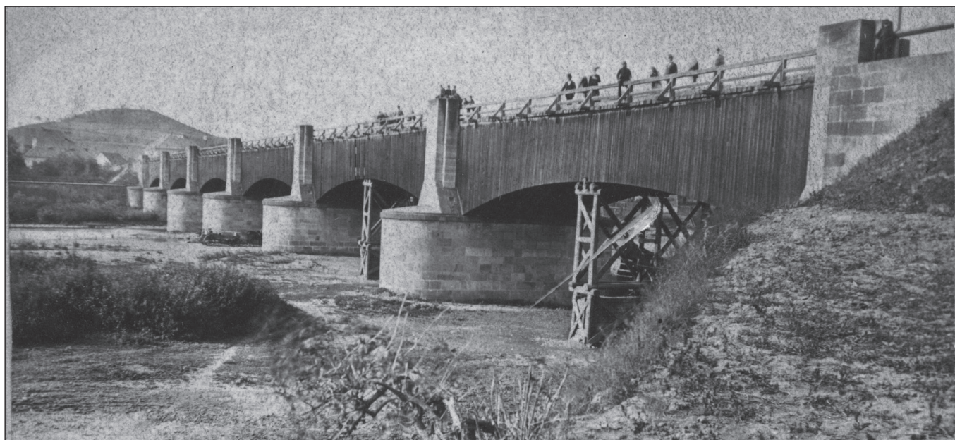
Obr. 1. Provizorní dřevěný most na původních kamenných pilířích Ferdinandova mostu. Fotografie J. Bendy z let 1879–1882.
