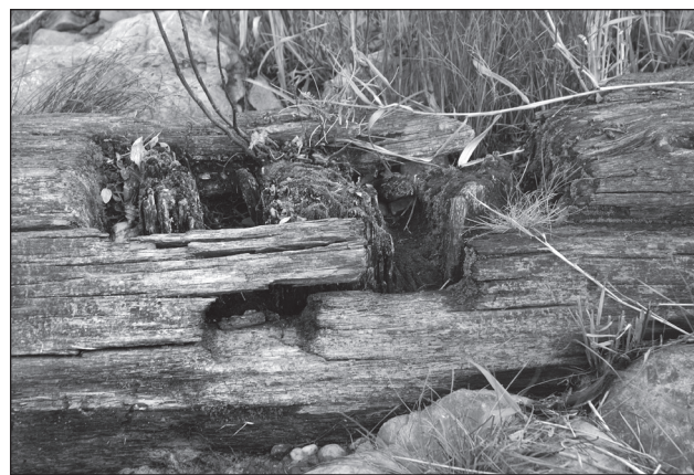
Obr. 4. Detail kotvení čepu svislé stojky v dlabu. Foto M. Majer.
