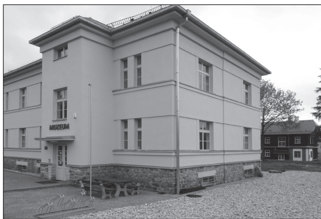
Obr. 2. Objekt stálé muzejní expozice „Vila“, stav po rekonstrukci, květen 2010. Foto M. Lang, květen 2010.
