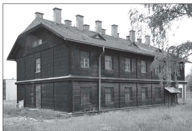
Obr. 3. Dřevěný objekt bývalých letních kasáren, stav před rekonstrukcí, květen 2009. Foto M. Lang.
