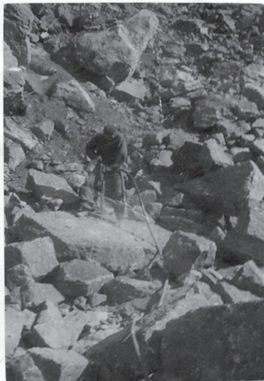
Obr. 2. Rozpojování nadměrných kusů rubaniny pomocí sbíjecích kladiv na stlačený vzduch – Modrý lom, počátek 50. let 20. století (archiv autora).
