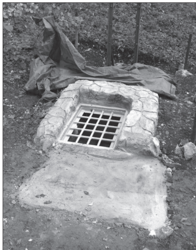
Obr. 3. Vstup do Studniční jeskyně těsně po vybudování nového uzávěru v roce 2008. Foto K. Žák.
