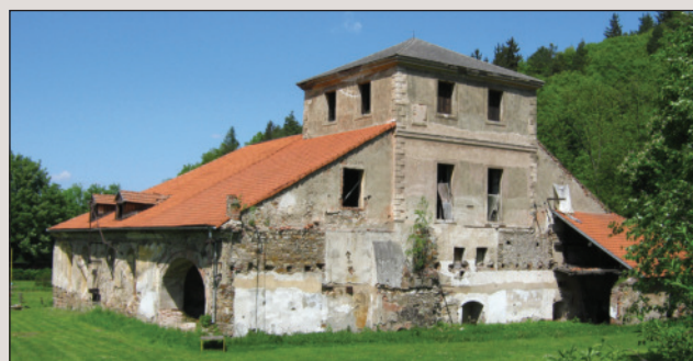
Obr. 1. Vysoká pec Barbora v Jincích. Foto P. Špryňar.
