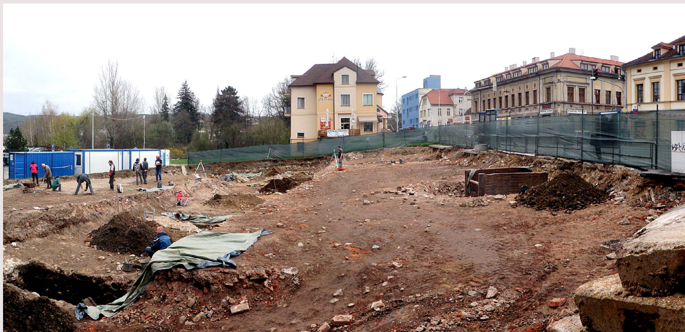
Obr. 2. Panoramatický záběr předmětného pozemku, pohled od Z. Fig. 2. A panoramic view of the studied area (a view from the west).
