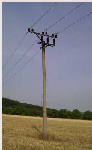
Obr. 3. Sloup elektrického vedení s napětím 22 kV nevhodného typu v blízkosti hnízda černých čápů v NPR Koda se stal osudným jednomu z mláďat v roce 2015. Foto F. Pojer.
