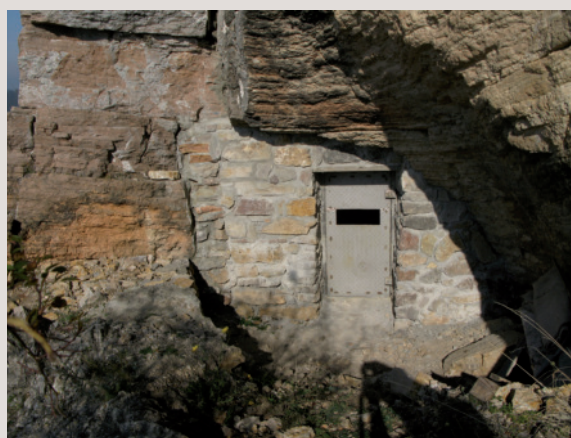
Obr. 4. Nový uzávěr vstupu do Nové propasti na Zlatém koni. Foto K. Žák.
