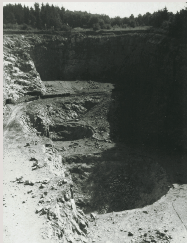
Obr. 3. Malá Amerika [E] v době těžby, pohled od Z. Na dně jsou viditelné dvě nálevky na 4. patro; za nimi vlevo od stojícího důlního vlaku pak vjezdy do Budňanského překopu 3. patra, dnešní Malá galerie. Fotoarchiv p. Potyše, 1944.
