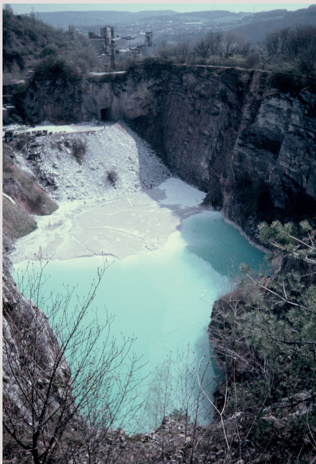
Obr. 2. Nové Dvanáctky [G] v době fungování odkaliště, kterému se dostalo lidového označení Azurové jezero. Otvor ve stěně v pozadí patří původní trase Budňanského překopu před jeho přeložením v r. 1952 kvůli postupující těžbě v lomu. Foto M. Kolčava 25. 4. 1992.
