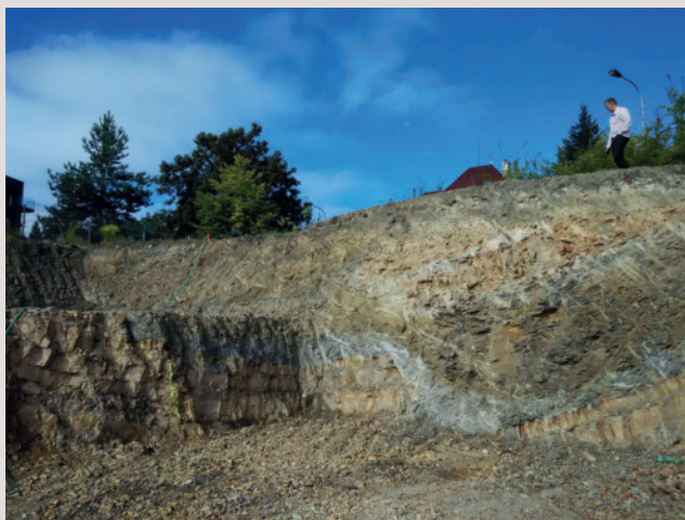
Obr. 10. Praha-Vokovice, zlom ve skaleckých křemencích a v břidlicích dobrotivského souvrství, lokalita 5A. Foto J. Peršín.
