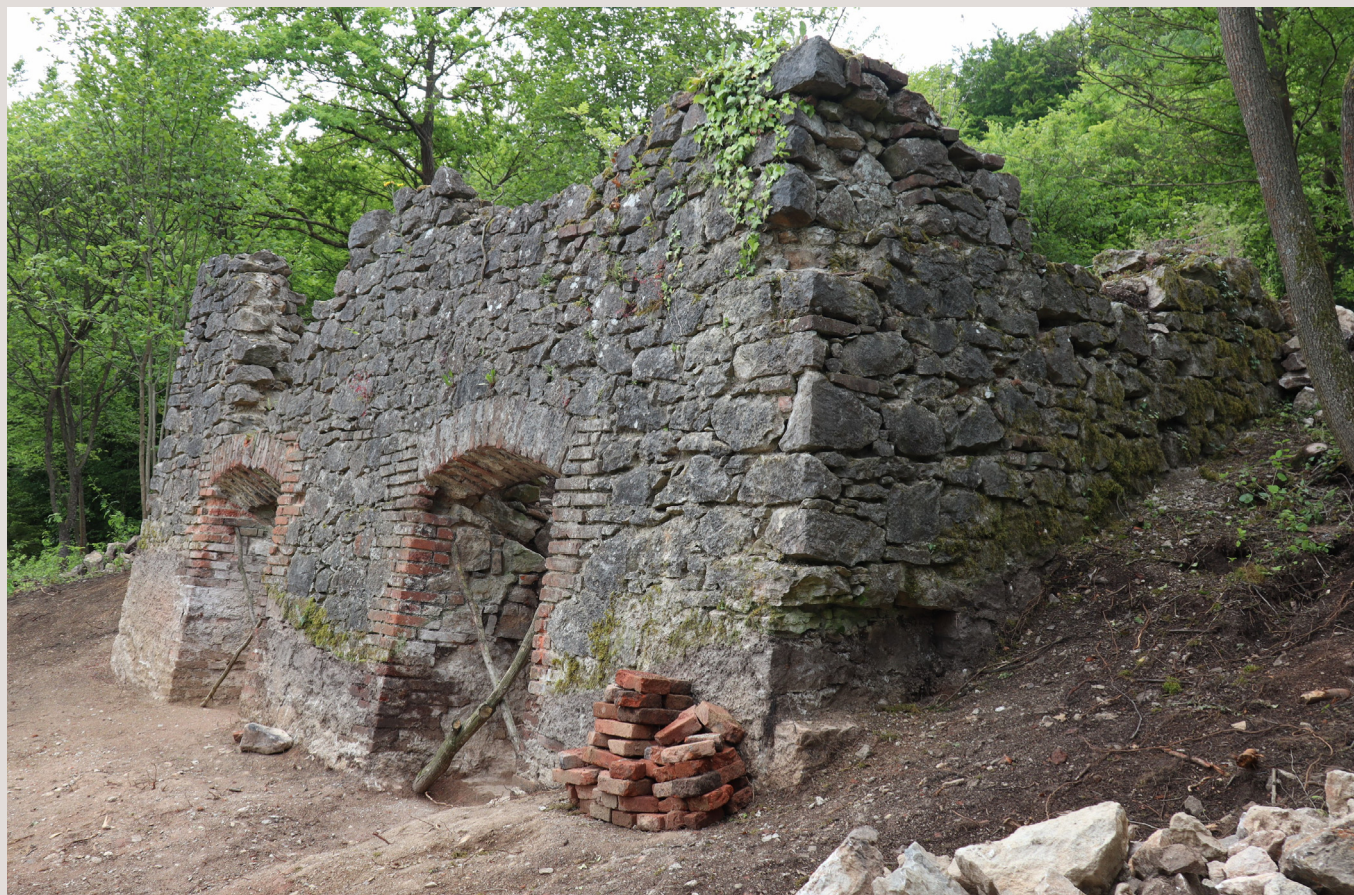
Obr. 3. Šachtová pec u Koněprus pocházející pravděpodobně z první poloviny 19. století je nejstarší dochovanou šachtovou pecí na Berounsku. Jedná se o dvoušachtovou pec unikátní tím, že topeniště jedné ze šachet zůstalo původní určené pro topení dřevem, topeniště druhé šachty bylo přestavěno na topení uhlím. Foto M. Hejna.
