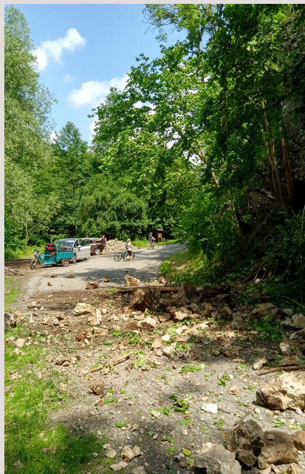
Obr. 2. Dne 26. června 2021 došlo na Rozštípené skále mezi Svatým Janem pod Skalou a Hostímí ke zřícení skalních bloků. Foto F. Vycpálek.
