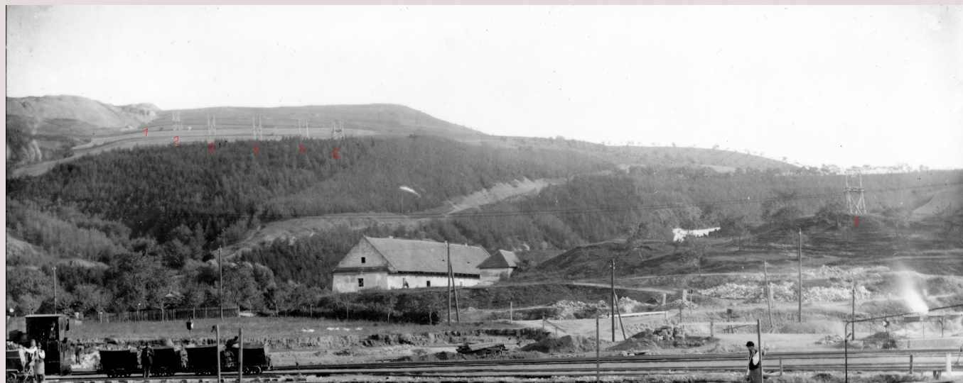
Obr. 3. Snímek lanovky z lomu Kosov do Královodvorských železáren. Nepříliš zřetelné dřevěné sloupy lanovky jsou očíslovány červenými čísly. Výřez z většího snímku, uloženého původně v podnikovém archivu Královodvorských železáren. Otisk a výřez B. Zeman již v 80. letech.
