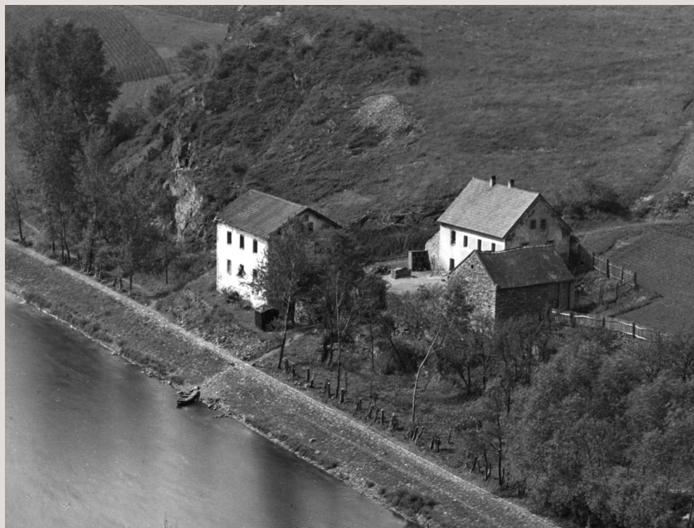
Obr. 2. Stav budov bývalého Vitáčkova mlýna v roce 1942. Veřejná cesta pro pěší tehdy šla pod mlýnem po koruně navigační hráze a právě tudy byla v roce 1944/1945 vedena provizorní stavební drážka (o ní viz dále v článku). Foto J. Jeníček.
