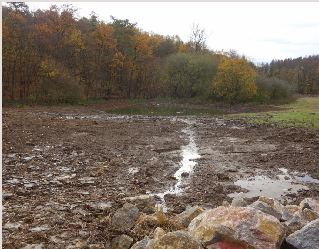
Obr. 7. Nové koryto Bubovického potoka mezi Horním mokřadem a Tůň (prosinec 2018, krátce po dokončení stavby). Foto H. Hofmeisterová.
