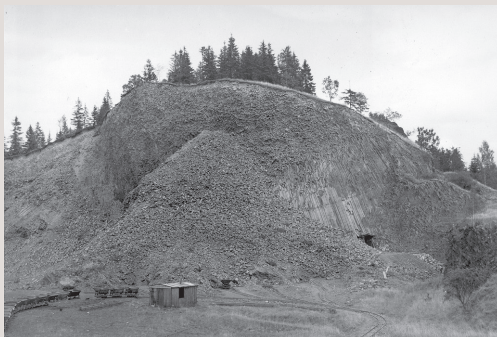
Obr. 2. Ideální rozval horniny po provedeném komorovém odstřelu ve vulkanických horninách – lom Rotava v Krušných horách. © Fotoarchiv České geologické služby, foto 6881, Bohumil Červený, 1954.
