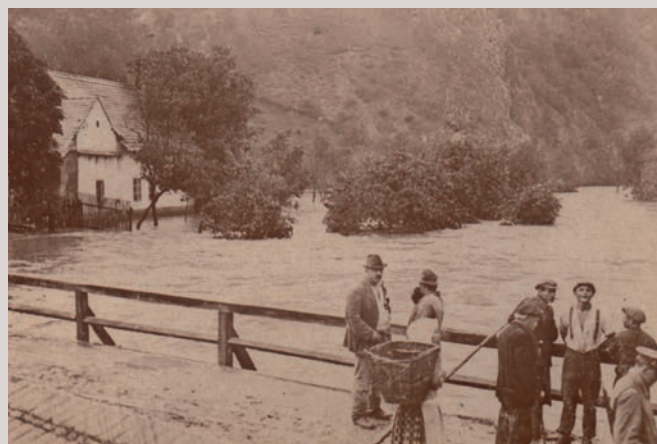
Obr. 9. Dřevěný most v Hostimi na nedatované fotografii, zřejmě při některé povodni v době první republiky, pravděpodobně v roce 1925. Z jedné strany datum pořízení snímku omezuje uniforma prvorepublikového četníka vpravo dole, z druhé strany fakt, že dřevěný most byl přestavěn na betonový v roce 1932. Soukromá sbírka.
