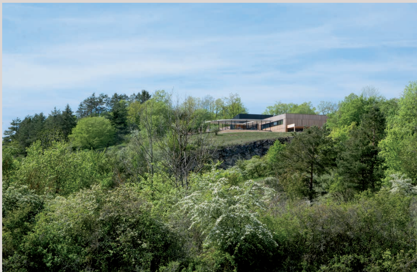
Obr. 1. Dům přírody Českého krasu, návštěvnické středisko CHKO Český kras a Koněpruských jeskyní vybudované v programu Dům přírody na návrší Zlatý kůň. Při projektu bylo dbáno na to, aby stavba výrazně nevyčnívala nad úroveň terénu. Foto M. Medková, aktualne.cz.
