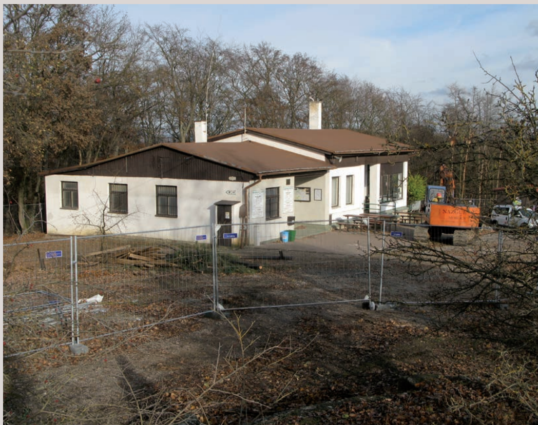
Obr. 2. Staré provozní budovy Koněpruských jeskyní původem z 50. let 20. století těsně před zahájením bourání v listopadu 2020. Foto K. Žák.
