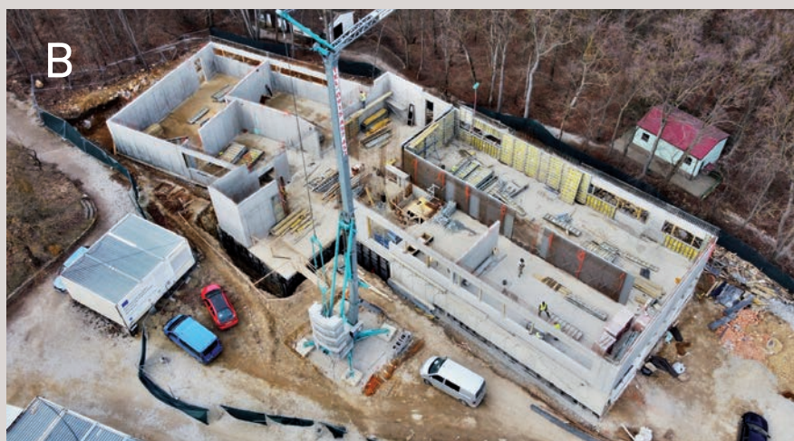
Obr. 4A, B. Postup výstavby Domu přírody na snímcích z dronu. V září 2021 byly dokončeny základy a v říjnu téhož roku základová deska. V únoru 2022 se už započalo rýsovat první podlaží. Foto V. Ekrt.
