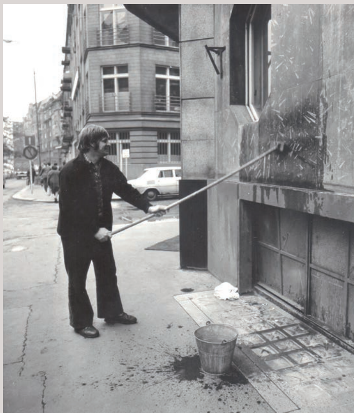
◀ Obr. 5. Jiří Kříž čistící hlavonožcové vápence na budově lázní v Praze-Smíchově na nám. 14. října. Archiv Š. Manda.
