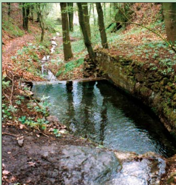
Umělá nádržka pitné vody pod krasovým pramenem v „Šanově koutě“. Foto: Jiří Kovanda
