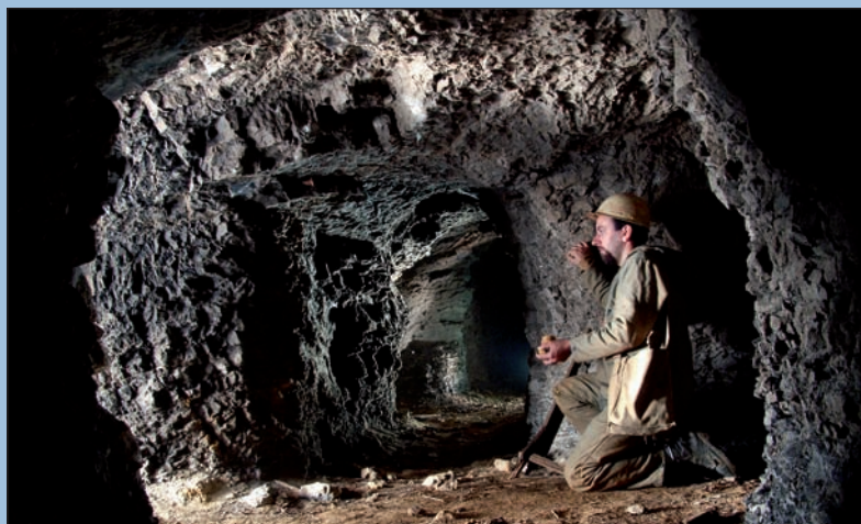
Foto 2. Pohled na křížení chodeb. Vpravo směr ke vchodu. V zadní části za křížením je patrná komora pro umístění trhavin.
