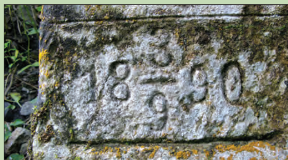
Foto 2. Typický vzhled povodňových značek na mostcích železniční trati mezi Berounem a Karlštejnem (značka povodně z 3. září 1890 na mostku v tratovém kilometru 32,465 u Srbska. Foto Karel Žák.
