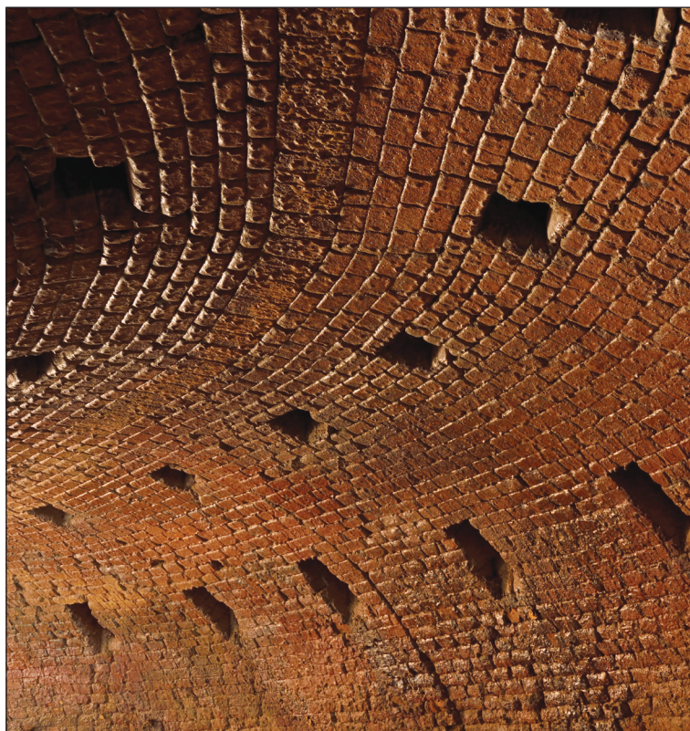
Z vápenky ve Zdicích zůstal stát jeden komín a jedna kruhová pec, skrytá v tovární hale firmy Narex Zdice, s.r.o. Obrázek ukazuje strop peciště. Foto M. Majer. The lime plant at Zdice was largely demolished, with only one chimney and one lime kiln surviving. The picture was taken inside the lime kiln chamber. Photo by M. Majer.
