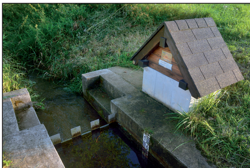
Hlavním pramenem, z jehož vod se vysrážely sladkovodní vápence ložiska Nesvačily, je Nesvačilská krasová vyvěračka. Na odtoku z pramene je dlouhodobě sledovaný měrný profil Českého hydrometeorologického ústavu. Foto M. Majer The main spring providing water for the precipitation of freshwater limestones of the Nesvačily deposit is the Nesvačily karst resurgence. The outlet of the spring is equipped with a gauge of the Czech Hydrometeorological Institute, allowing a long-term monitoring of the spring discharge. Photo by M. Majer.
